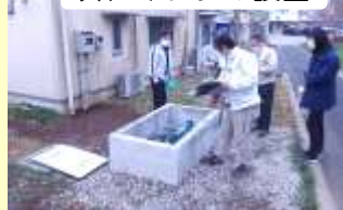
井戸ポンプの設置
