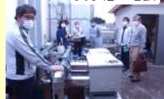
受水槽の増設
