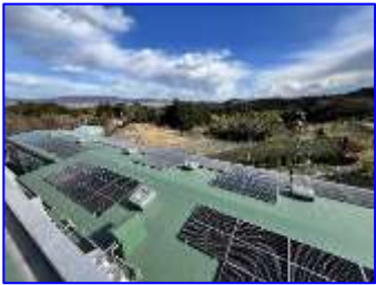
太陽光発電システムの整備
